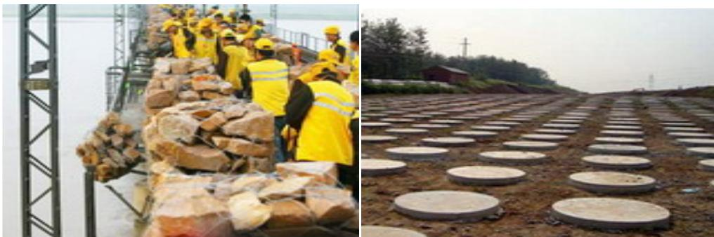
💡CFG 桩：桩体中加入水泥和粉煤灰形成了高黏结强度的桩，改善了碎石桩的刚性，不仅能很好地发挥全桩的侧摩阻作用，也能很好地发挥其端阻作用，CGF 桩和桩间土、垫层一起形成复合地基。
