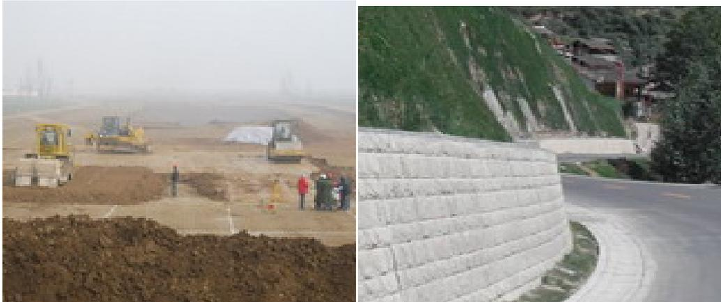
🔦设置护坡：包含骨架护坡、片石护坡、植被护坡、挡土墙护坡、水泥土护坡等。膨胀土边坡不宜采取单一的防护措施，且植被防护与工程防护相结合防护效果好。
