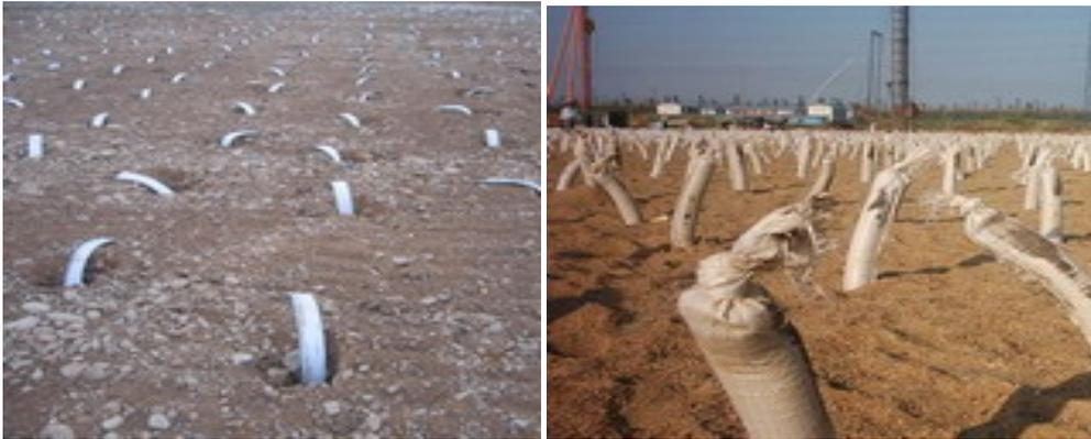
💡袋装砂井：在合成纤维编织袋内充填中、粗砂构成的砂袋，装入地基孔内，以加速地基排水固结。
